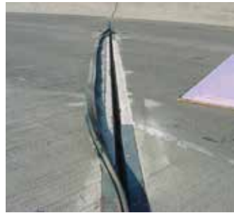
受损的接缝
